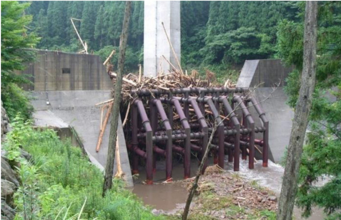
透過型砂防堰堤による流木の捕捉状況(熊本県小国町)
