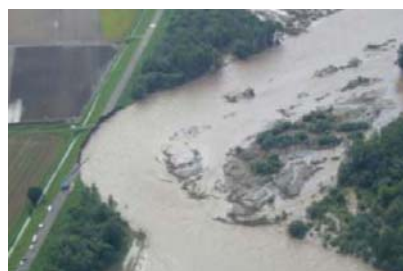
音更川の堤防流出箇所 1)
