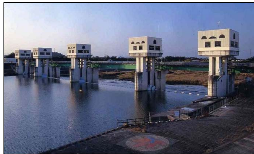
図-3 平成大堰(山国川河川事務所HPより)
