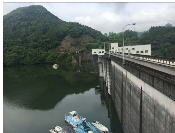
図-4 耶馬溪ダム
